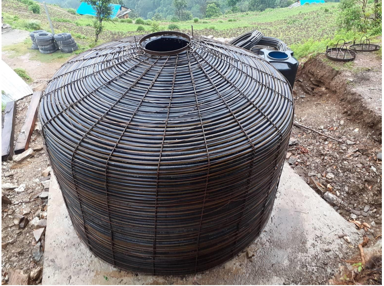
खानेपानी योजनाको Reservoir ट्याङ्की निर्माण हुदै
